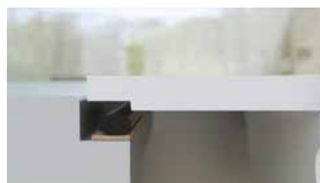
Passgenaues Einlegen der Spüle in die ausgeschnittene Arbeitsplatte.
