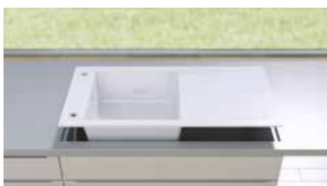
Fräsung der Arbeitsplatte. Hierbei die Ausschnittmaße nach Herstellerangaben beachten.
